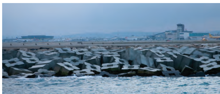
Consolidation de la digue
