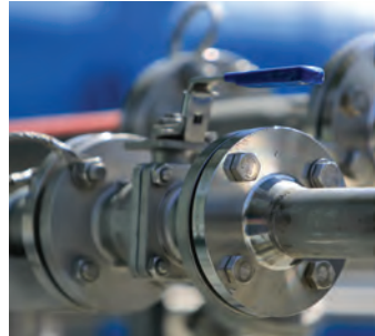
Rénovation du dépôt carburant
